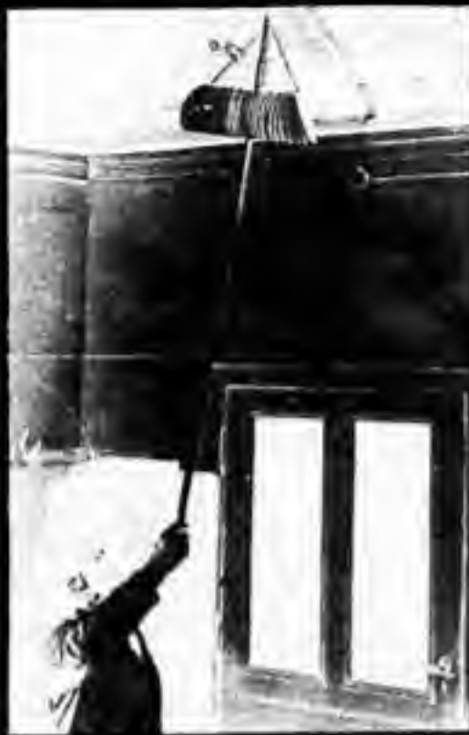
Abb. 7. Entwesung mit TRITOX. Aufhängen der Verdunster.
